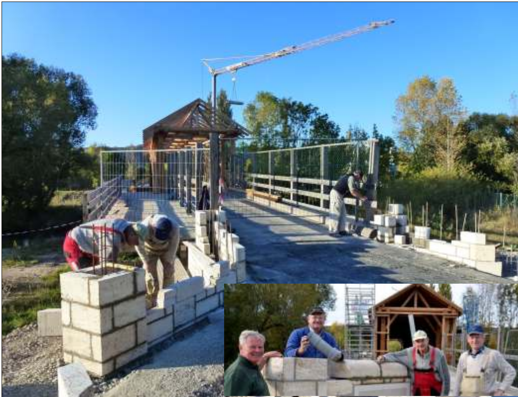
Günther Jackisch, Erwin Schulz und Lothar Schlegel beim Setzen der Mauern und später mit Werner Mautsch beim Versenken der Hülse mit Zeitdokumenten
